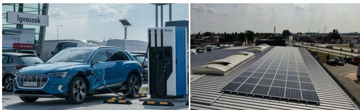
Salon Ignaszak w Kaliszu z instalacją fotowoltaiczną o mocy 50 kW
